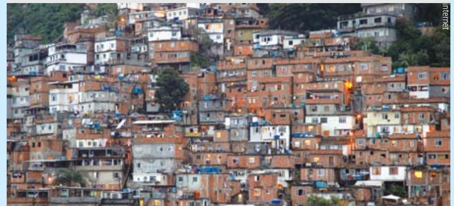
No Rio de Janeiro dos pobres: habitações em áreas de risco
